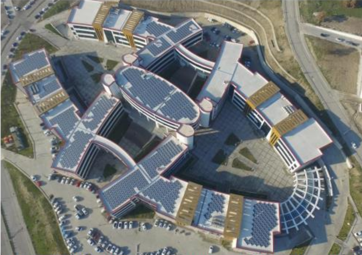
Mühendislik Fakültesi Binası Çatısına Kurulu MCBÜ Güneş Enerji Santrali
